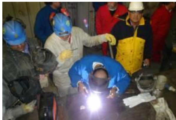
Methanex Reparando turbina con Magna 210
