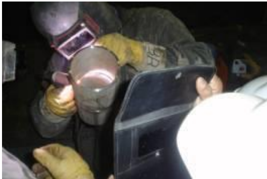
Methanex soldando con Magna 39 pipes
